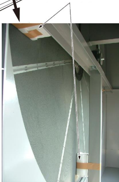
端面固定用泡沫聚苯乙烯 (转轮直径小于 2650mm)
